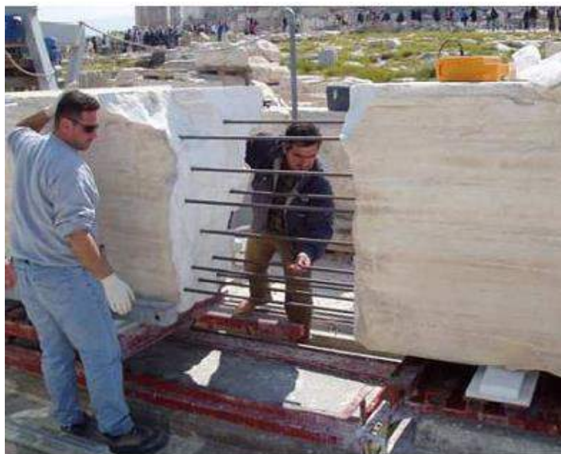
Συγκόλληση θραυσμένου επιστυλίου των Προπυλαίων με βάση δεδομένα από σχετική πειραματική διερεύνηση στην Εργαστηριακή Μονάδα «Φυσικών Δομικών Λίθων» του ΕΑΥ/ΕΜΠ
